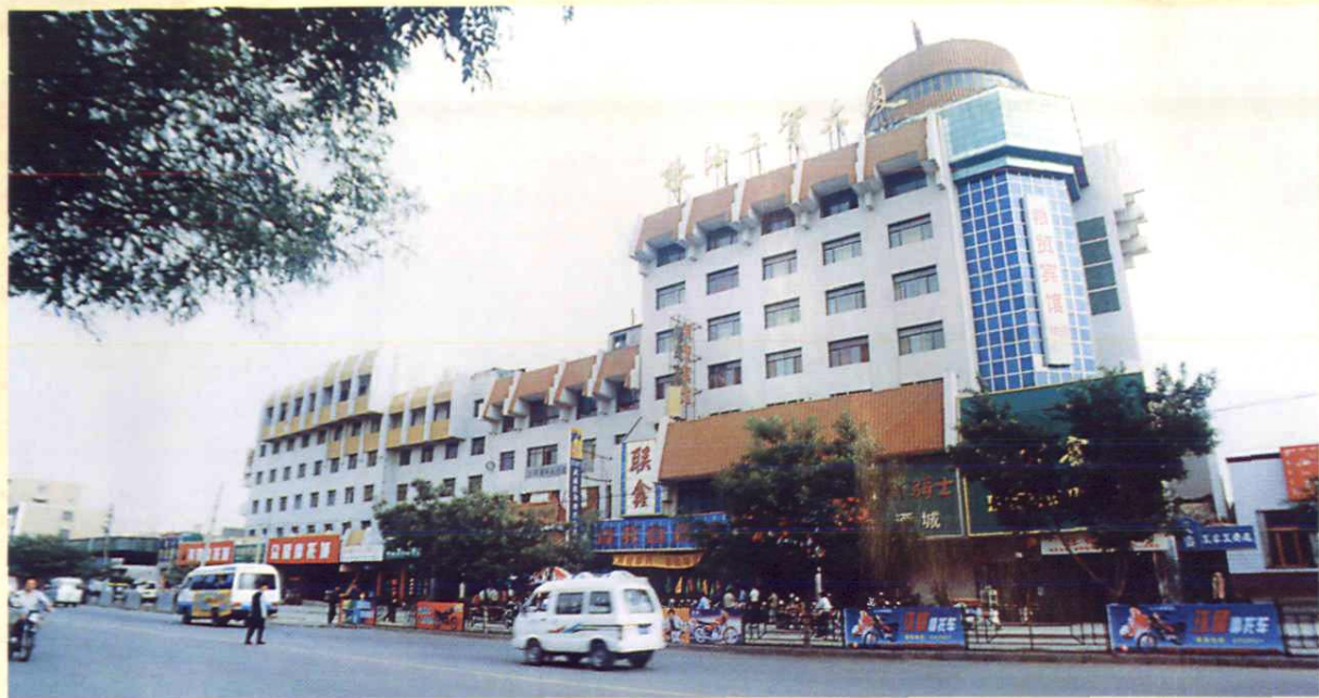
武威市植物油有限公司创办的粮油工贸大厦
