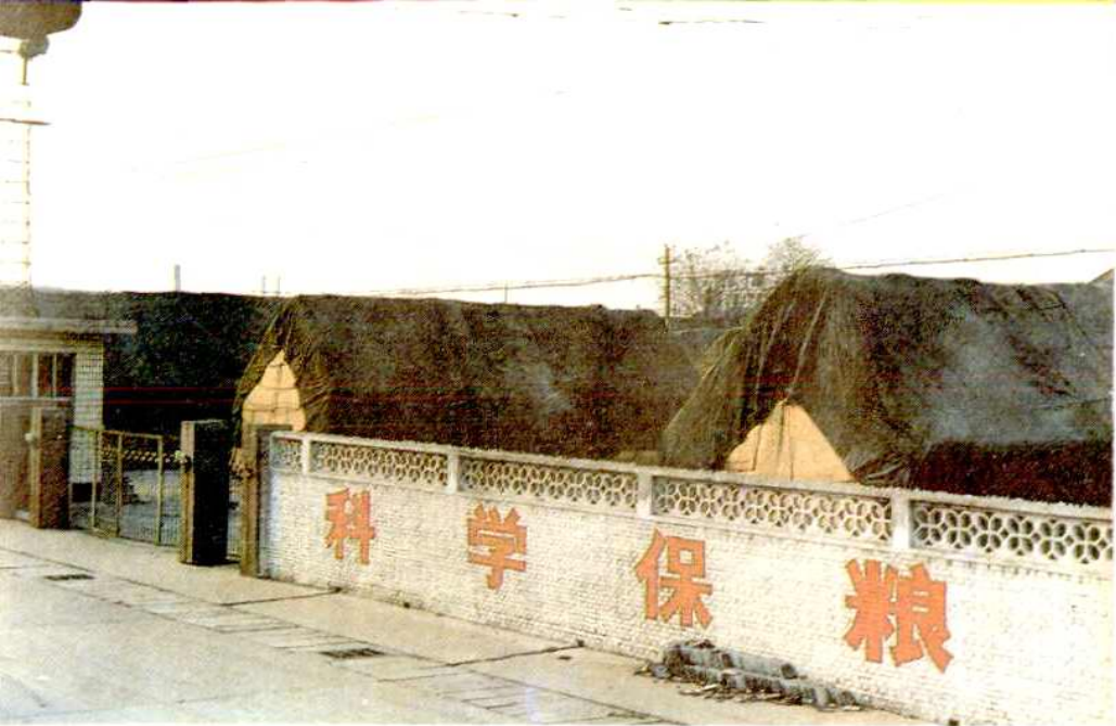
粮食转运站仓库区
