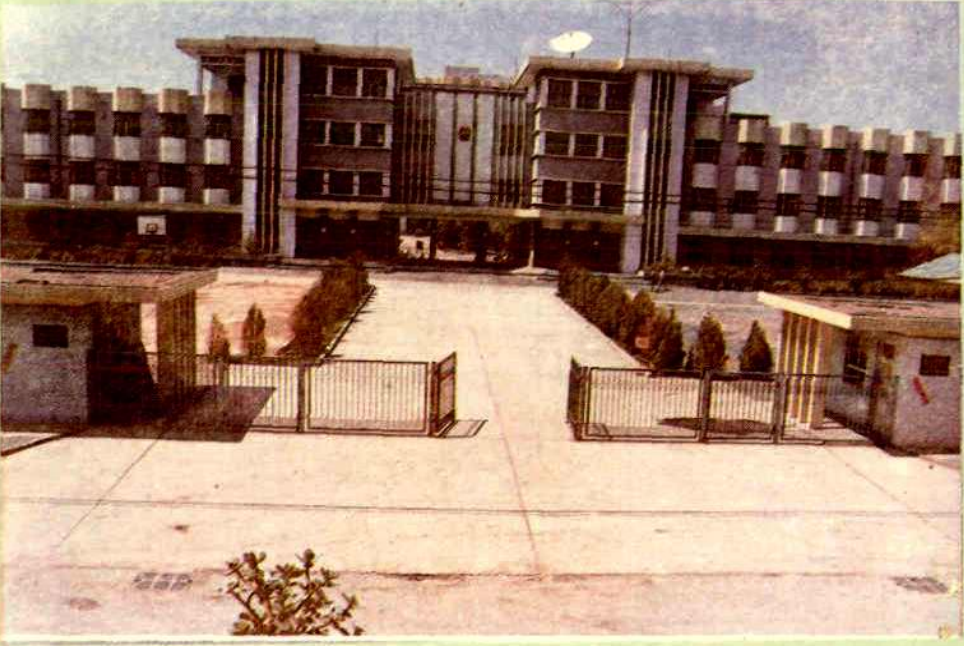
运城地区面粉厂新建的大门与办公楼
