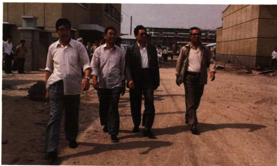
中国石油天然气 总公司副总经理 周永康（左三）、 副局长杨维庆 （右一）视察热电厂 扩建工程
