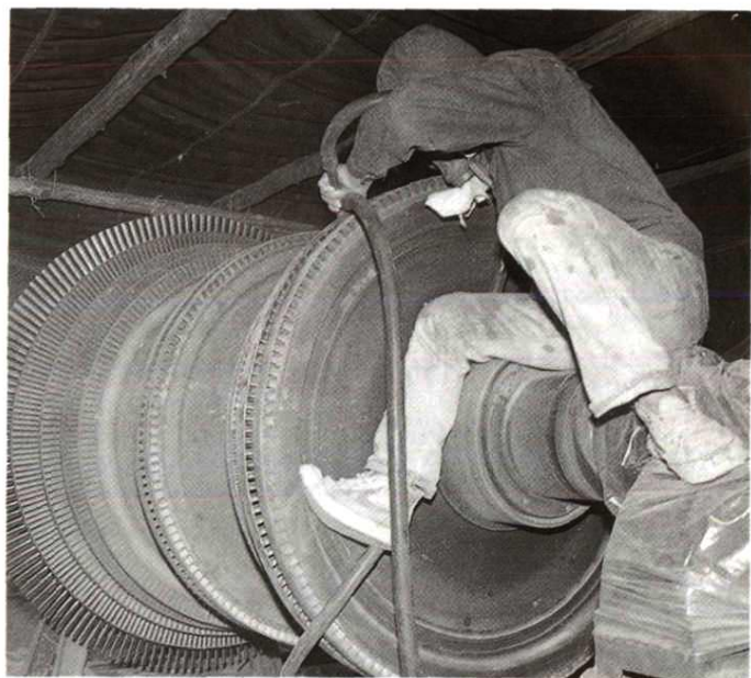
利用喷砂技术对汽轮机转子除垢
