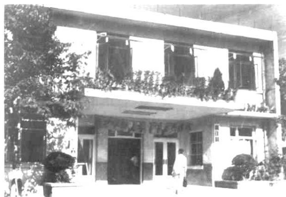
▲ 县人民医院旧门诊部
