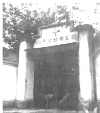
▲ 永宁镇卫生院旧址
