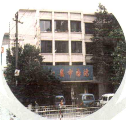
◀ 县中医院门诊部
