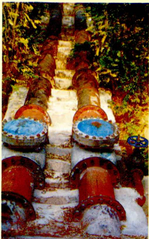
▲ 西村抽水工程管道
