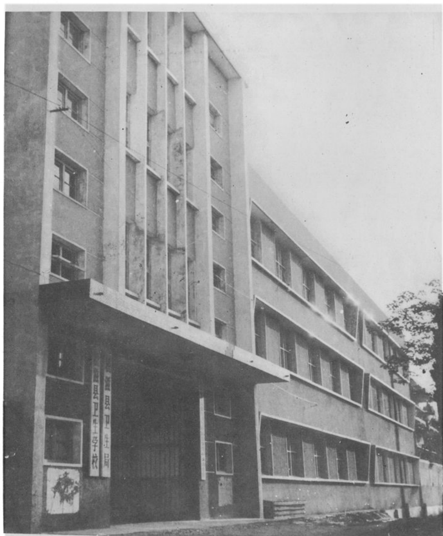
松滋县卫生局办公大楼
