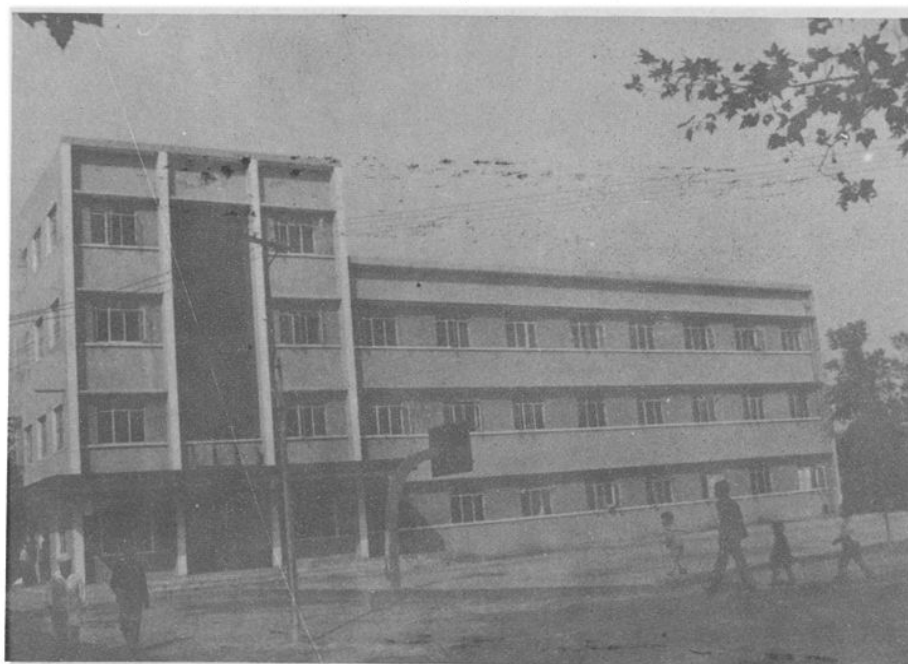
街河市中心卫生院住院部大楼
