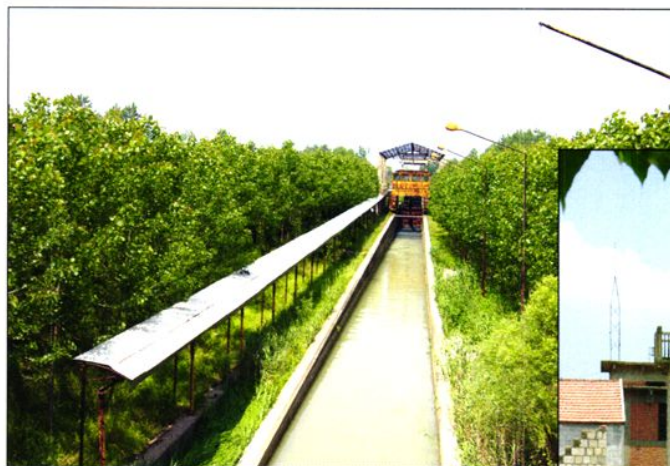
沭阳水坡工程
