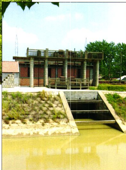
桑墟电力排灌站
