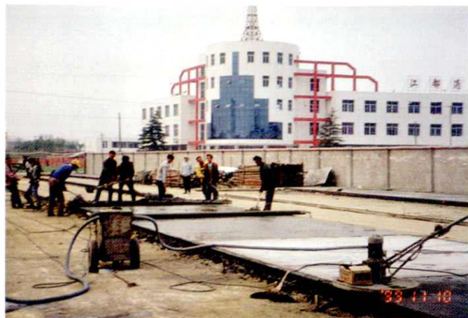
交通局检测中心施工场地
