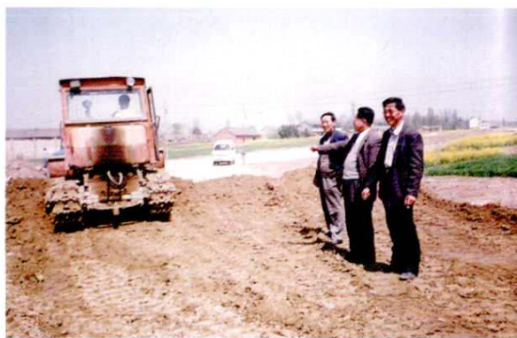
同三高速公路杨庄道口施工场地
