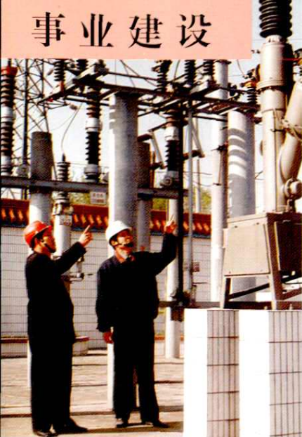
樊川供电所 领导来杨庄检 查指导农网改 造工作
