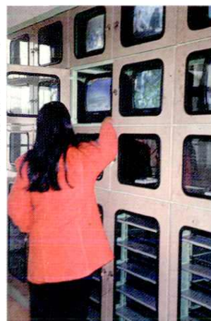
有线电视监控中心
