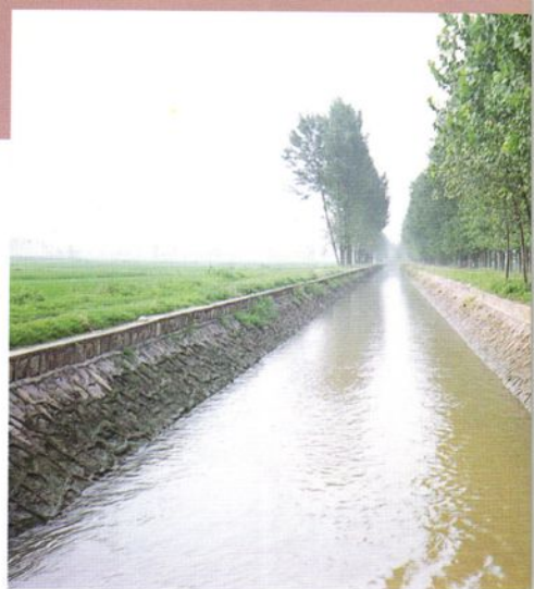
南灌区一支渠正在放水浇地
