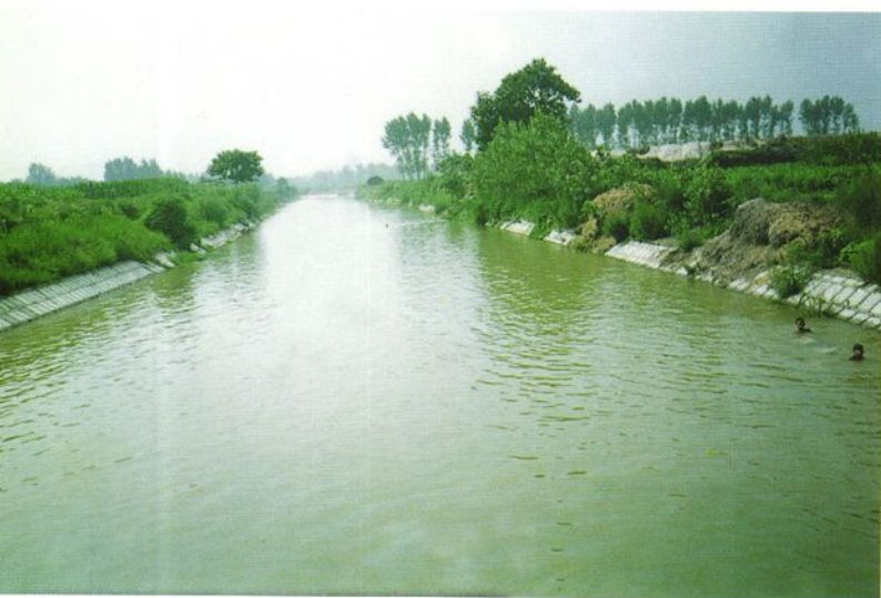
白龟山水库南干渠正在放水
