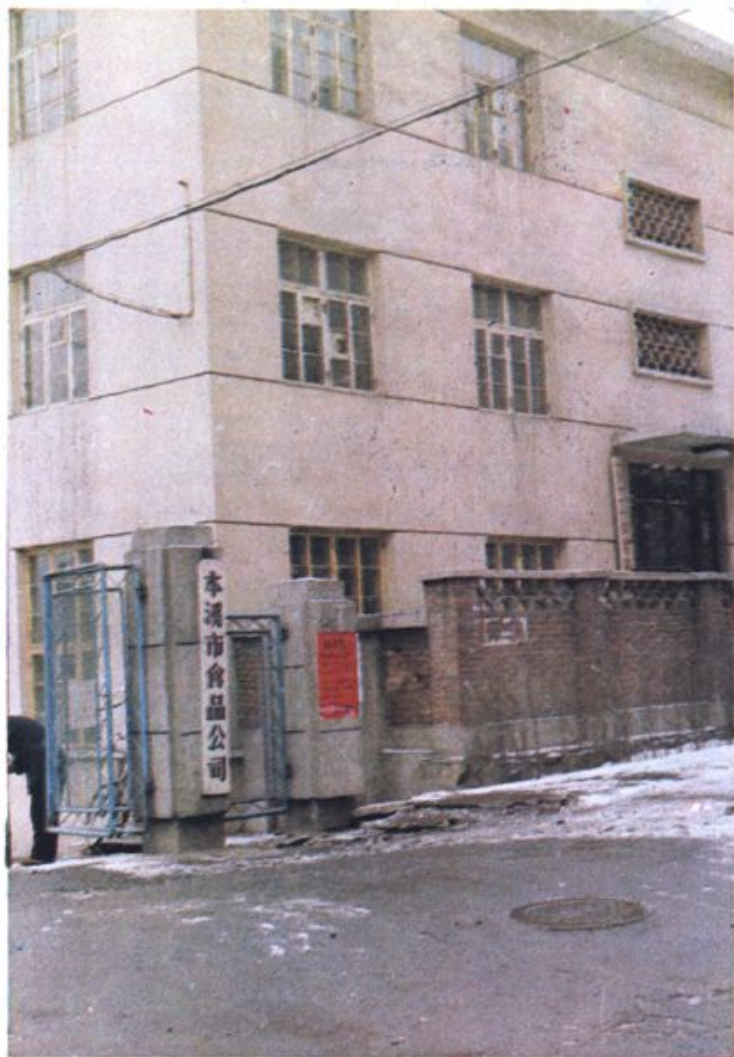
◀ 市公司办公楼
