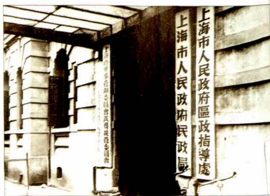
解放初上海市人民政府民政局办公楼
