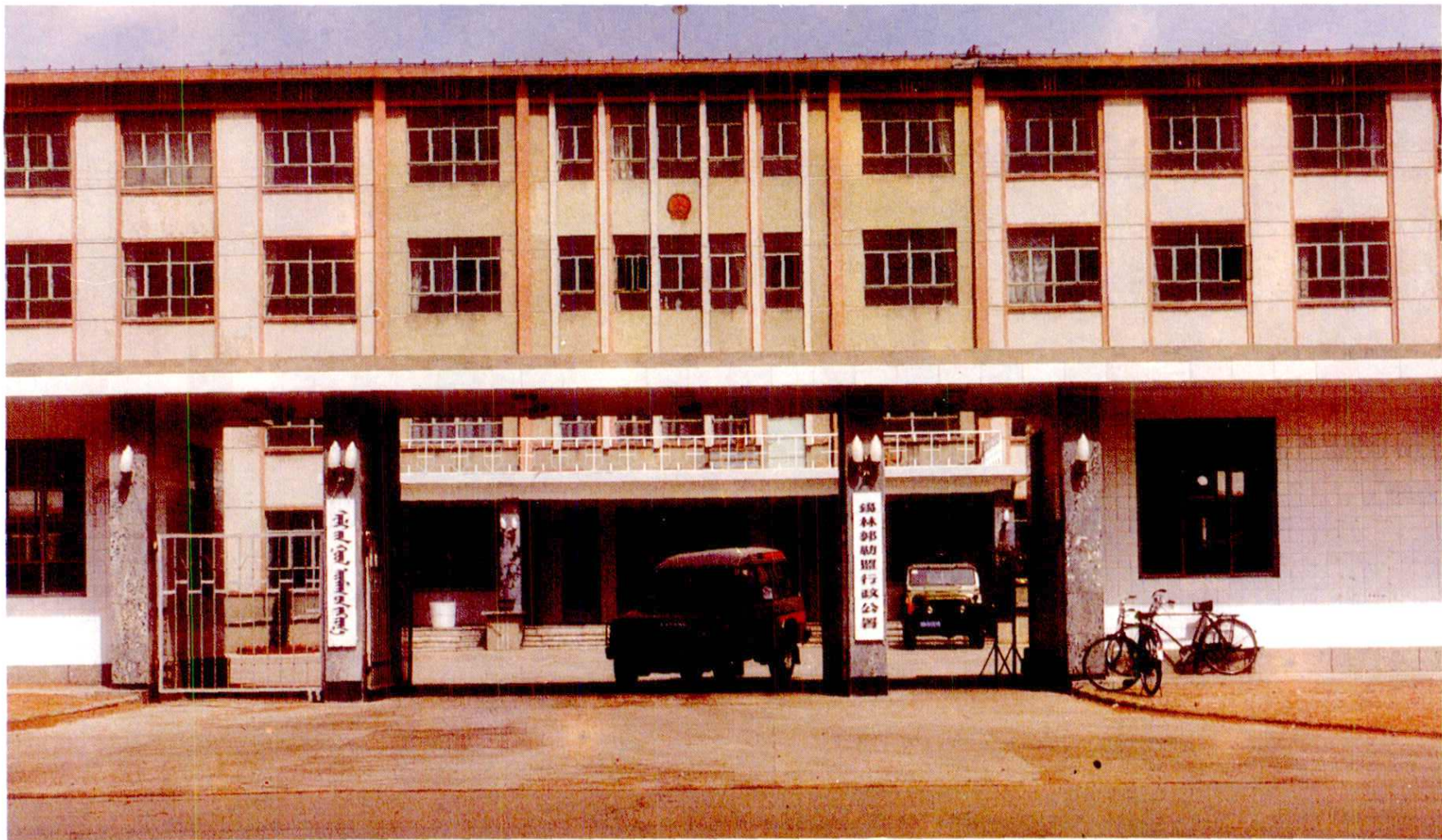
锡林郭勒盟行政公署办公楼
