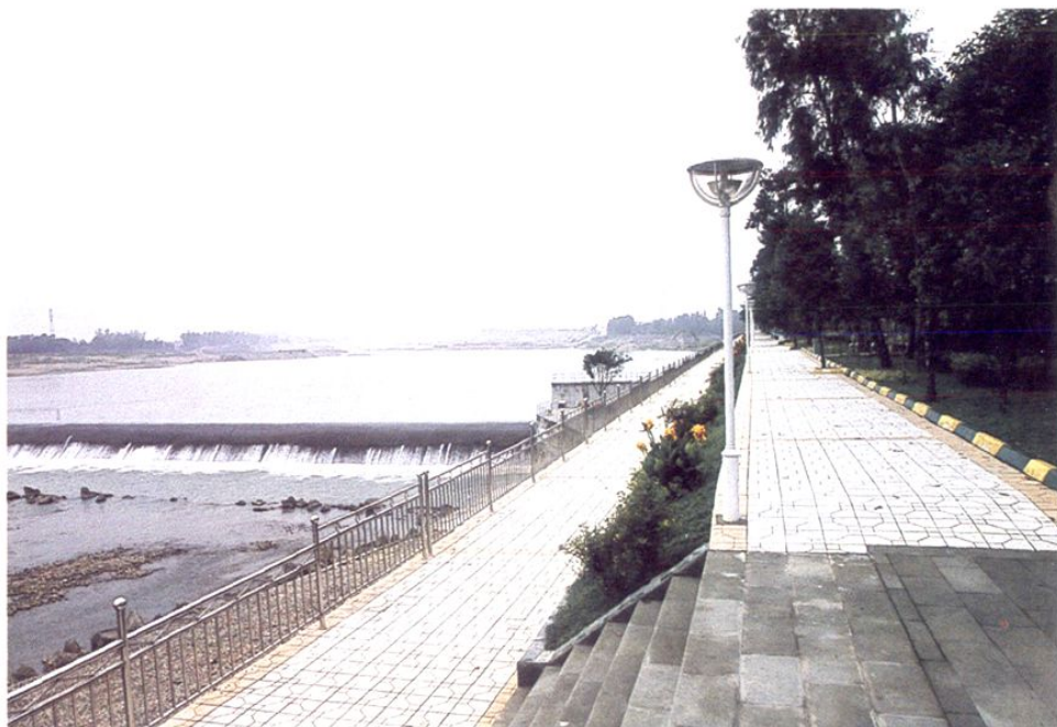
成都市岷江自来水厂段堤防工程
