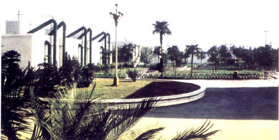
成都市双流西南航空港供水工程有限公司厂区
