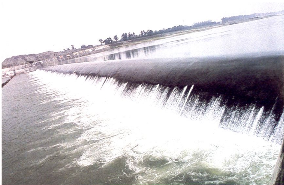
成都市岷江自来水厂取水口拦河大坝
