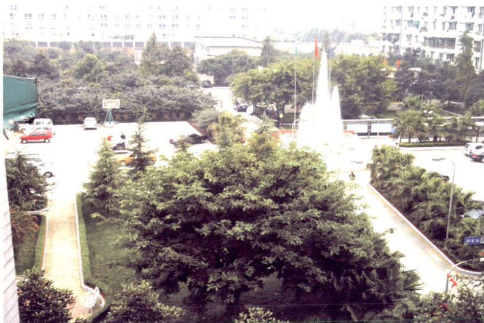
成都市岷江自来水厂厂部
