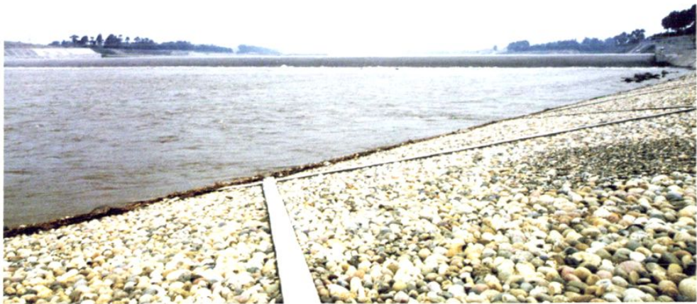
金马河成都市岷江自来水厂取水口段复式河床
