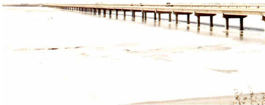
独流减河上的“千米桥”
