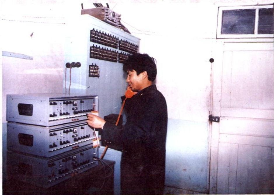
分支机构载波机务员测试电路
