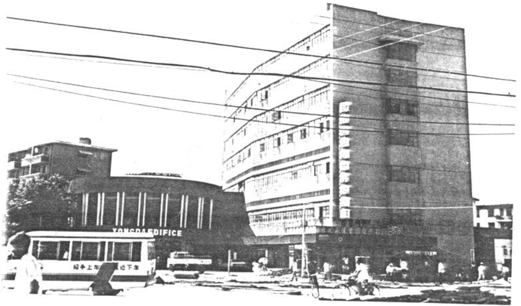
位于合肥市金寨路绩溪路口的合肥市供销社永达大厦，为全市六大商场之一。
