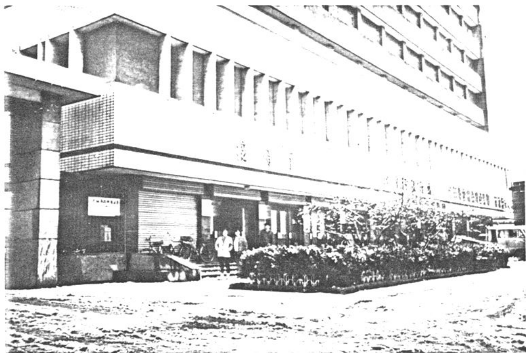
图为位于合肥火车站附近土产日杂公司招待所,为南北客商所欢迎。
