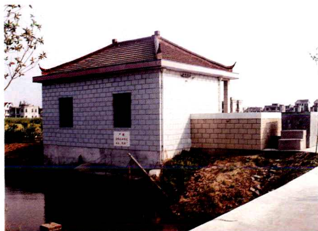
二墩村电灌站。
