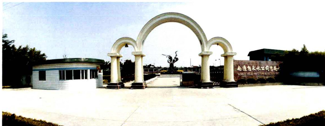
坐落在三墩镇二团村大治河北岸的南汇自来水公司惠南水厂。
