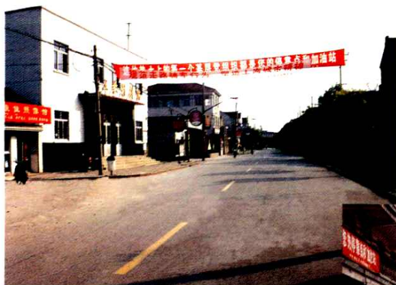
三墩镇洪通路。
