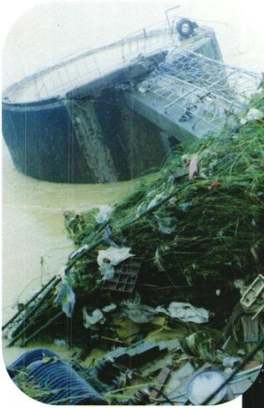
◀ 被“1998.6.22”特大洪水冲毁的水西制水厂抽水泵房
