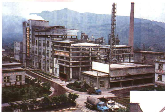
年产磷铵3万吨、硫酸4万吨、合成 氨1.5万吨的江安化工集团有限公司
