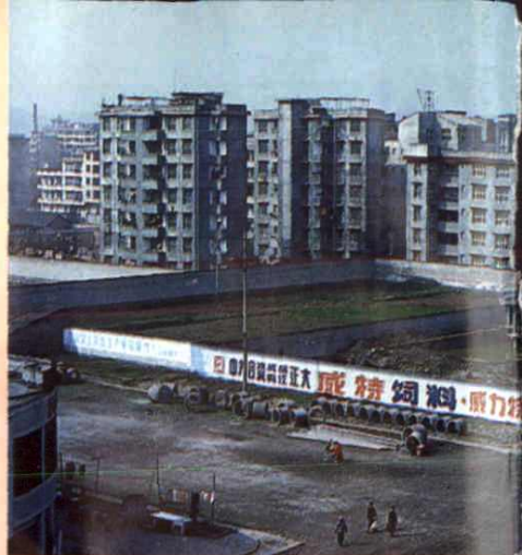
建设中的开发区
