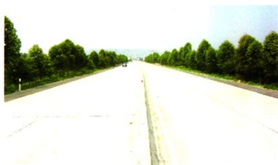
省道 S113 广高线天堂路段（路基宽 24 米、双向 4 车道）水泥路面
