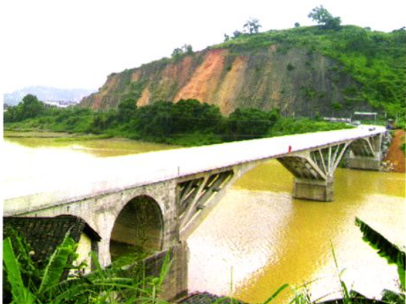
1992年6月建成通车的省道S368云古线南江口大桥，桥长177.03米，桥面宽8.5米
