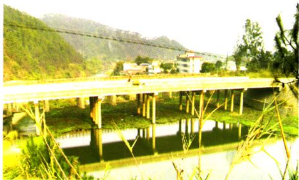
2002年4月建成的省道S113广高线良洞大桥，桥长138米，桥面宽21.5米
