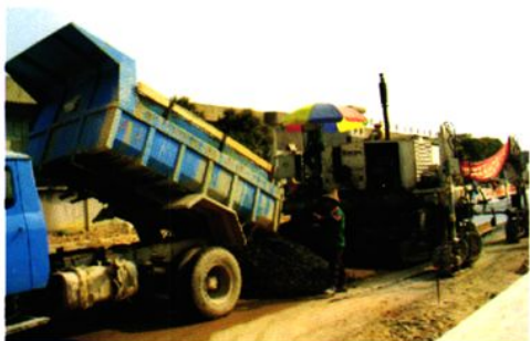
六祖大道改建工程施工现场（图3）
