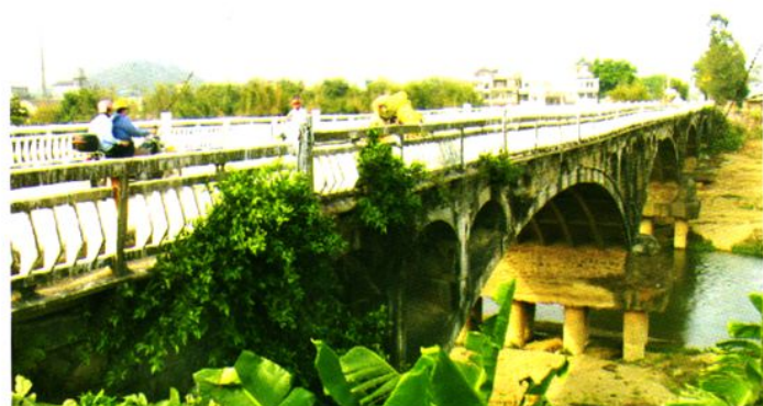
建于1975年11月的村道Y007黄东线新江双曲拱大桥，桥长145米，桥面宽9.5米
