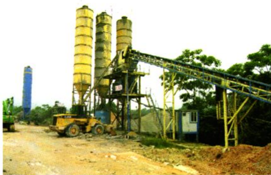
六祖大道改建工程施工现场（图5）
