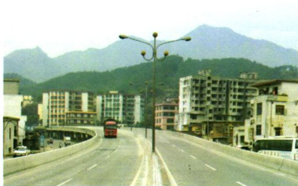
1998年6月建成通车的国道G324福昆线高峰立交桥，桥长560米、宽18米
