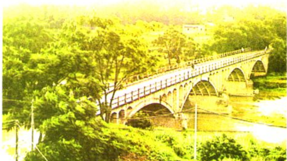
1954年建成通车的省道S352荔朱线菴濮大桥，桥长124.5米，桥面宽3米
