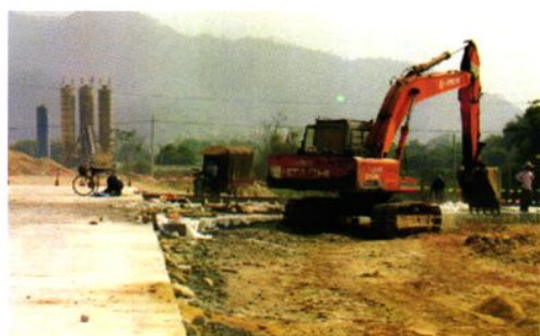
六祖大道改建工程施工现场（图4）
