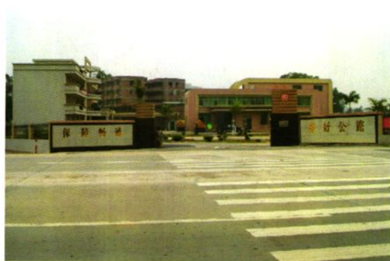
2005 年建成的罗定市公路局围底养护中心
