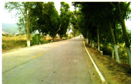
罗定市县道 X476 冲蒌线 K21+900 路段
