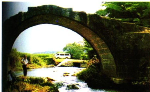
石硖陂桥 位于罗定市金鸡镇右铺墩村，始建于明万历三十三年（1598年）清乾隆十一年（1746年）重修，其后屡有修建，为砖筑单拱平桥，长10米，宽2.25米，高8米。现桥尚好
