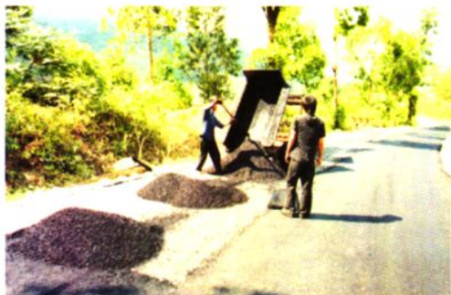
2001年10月，S276线沥青路施工中的里洞路段
