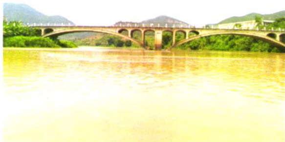
1983年1月建成通车的县道X472大镇线宋桂大桥，桥长161米，桥面宽8.5米
