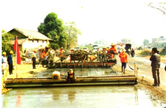
省道 S352 线改建施工现场（图2）
