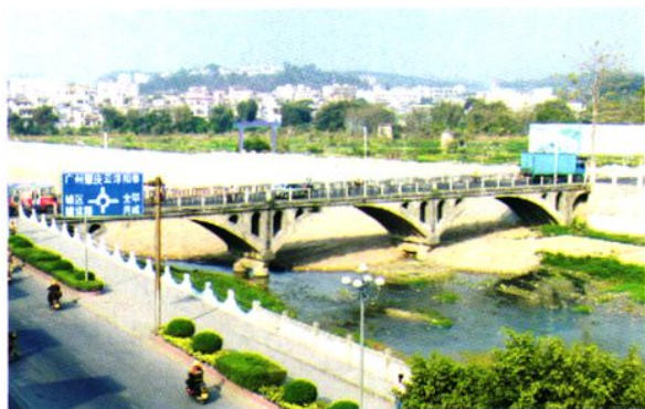
1971年3月建成通车的县道X483新共线东山庙双曲拱大桥，桥长77.8米，桥面宽7米
