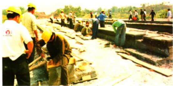
省道 S352 线改建施工现场（图1）
