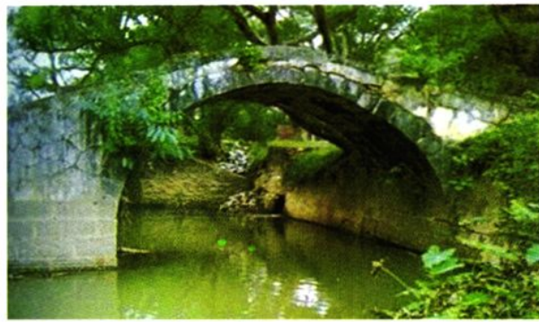
金鸡岭石拱古桥 位于罗定市金鸡镇庙岗村委，建于明万历年间
