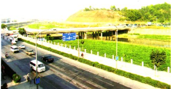
1996年2月8日建成的省道S113广高线广兴大桥，桥长117.8米，桥面宽25.6米
