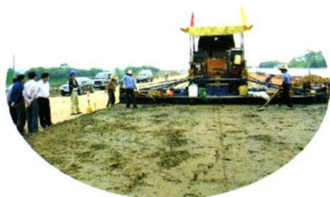
六祖大道改建工程施工现场（图1）
