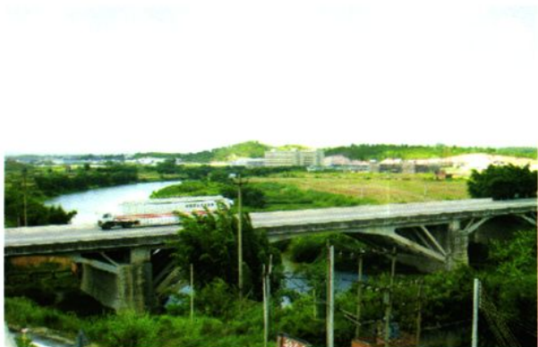
1993年8月建成通车的国道G324线围底大桥，桥长143.2米、桥面宽21.3米
