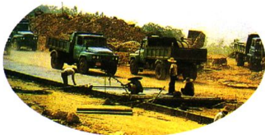
1993年，改造中的国道G324线冲花至罗城路段施工现场
