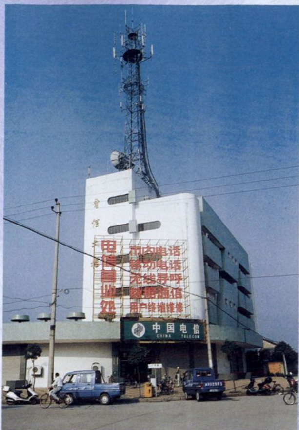
电信大楼(1991年5月竣工)
