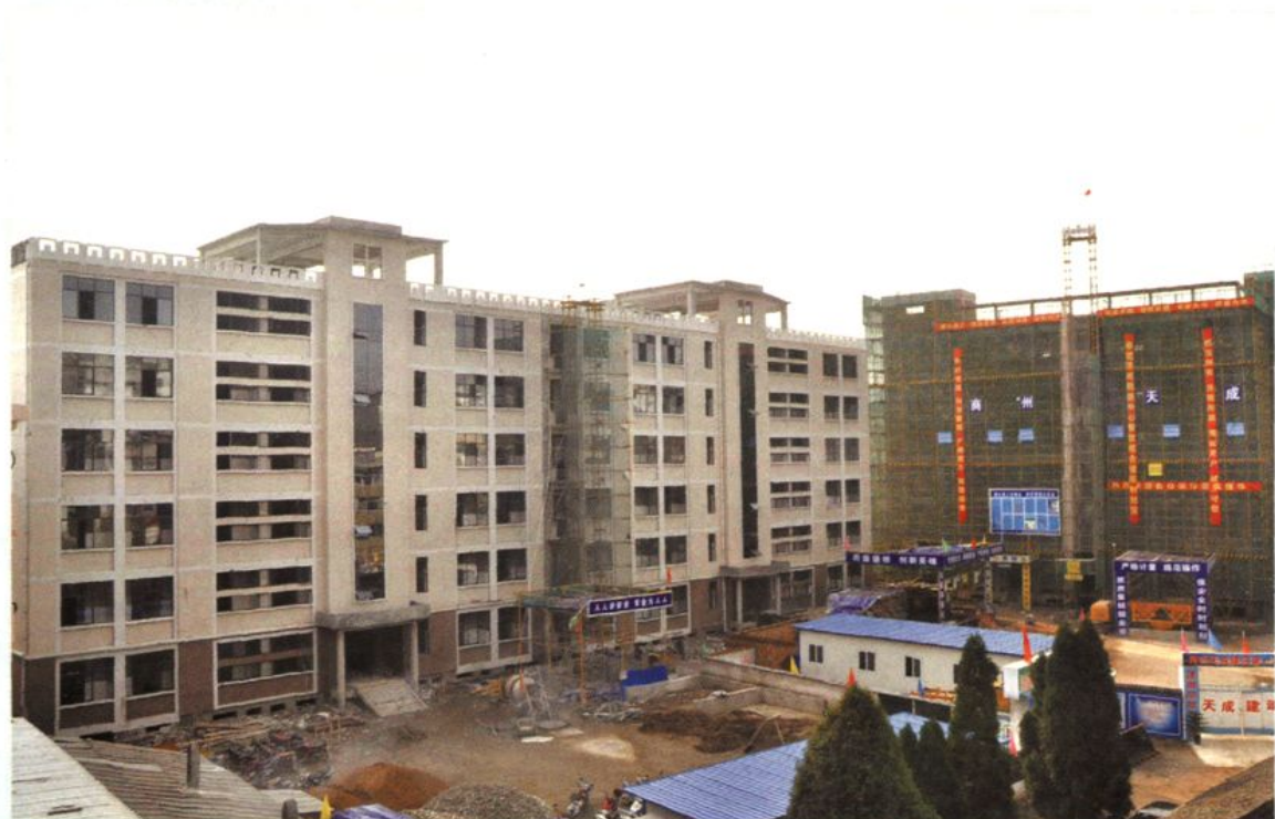
在建中的学生公寓楼、餐饮大楼
