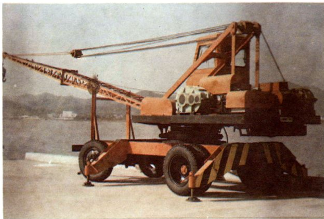
盐运码头吊车
