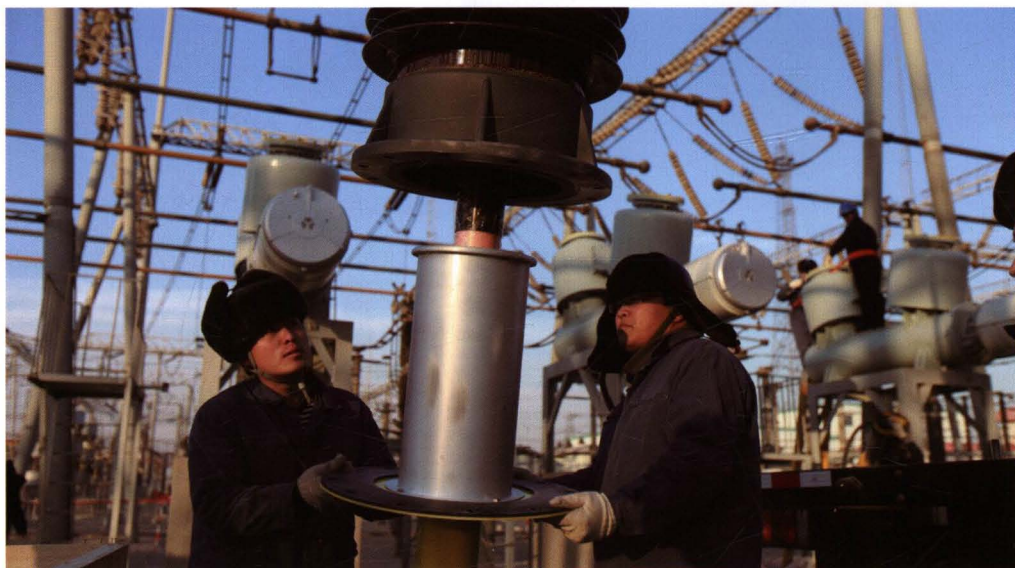
自主完成开关设备更换
