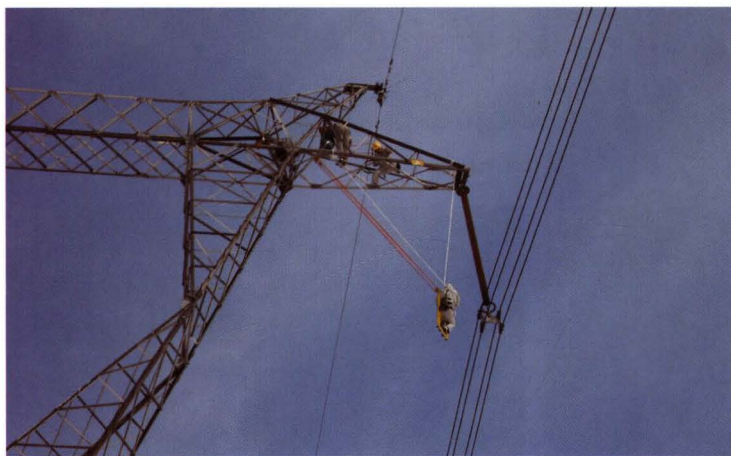
高空作业更换绝缘子串
