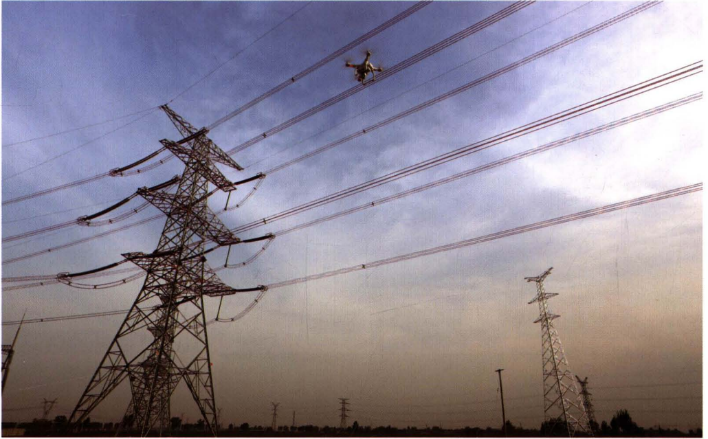
开展无人机巡视线路
