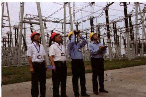
北京奥运保电巡视
