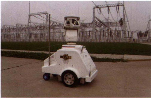
智能机器人巡检变电站
