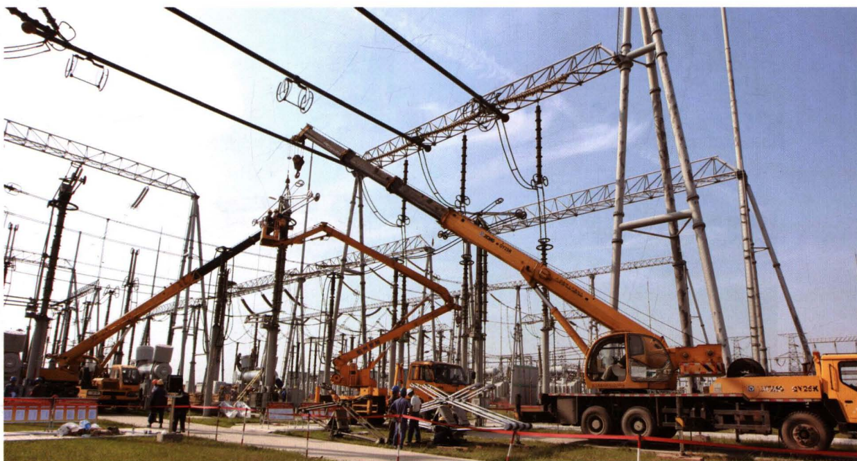
500千伏断路器及隔离开关大修
