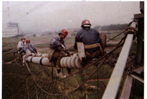
检修河北南网第一条500千伏输电线路--上徐线
