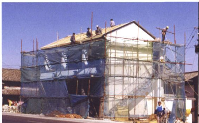
[图16] 大理市仁里邑民房整治在施工中
