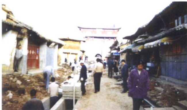
[图23] 整治巍山南诏文化街施工
