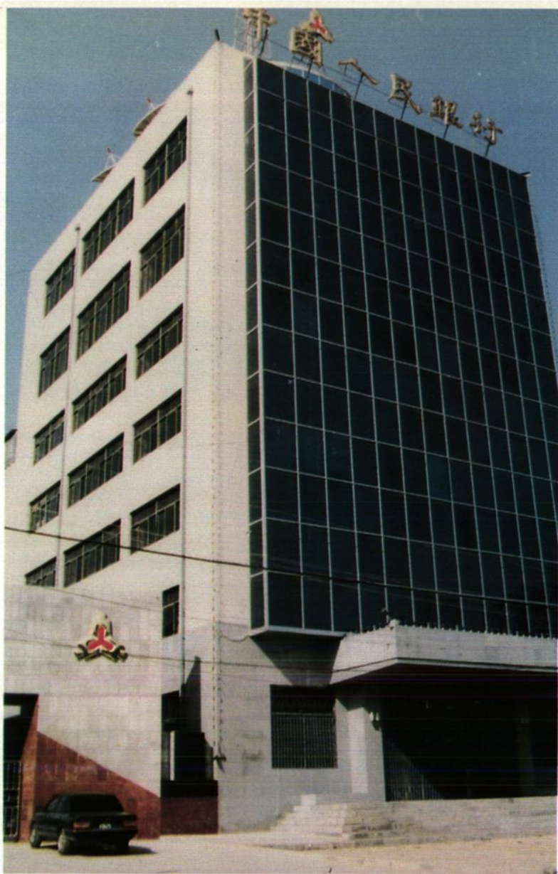
中国人民银行渭南地区分行办公楼
