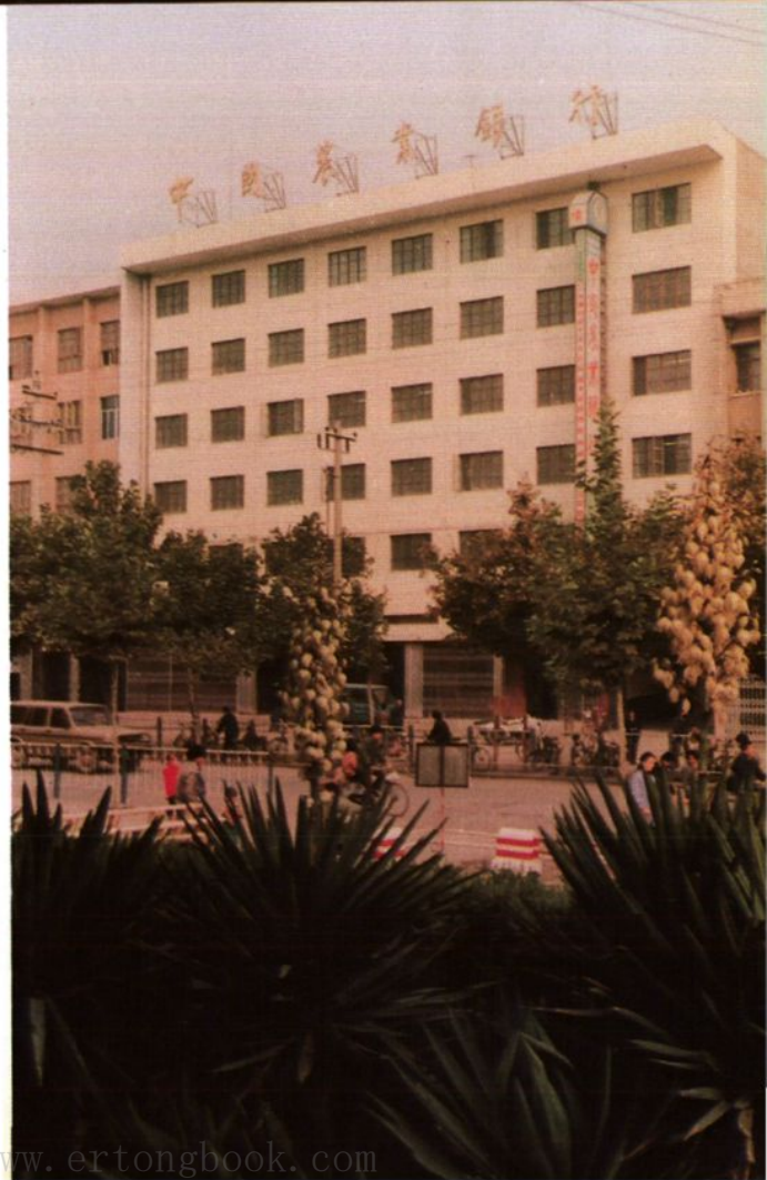
中国农业银行渭南市支行办公楼
