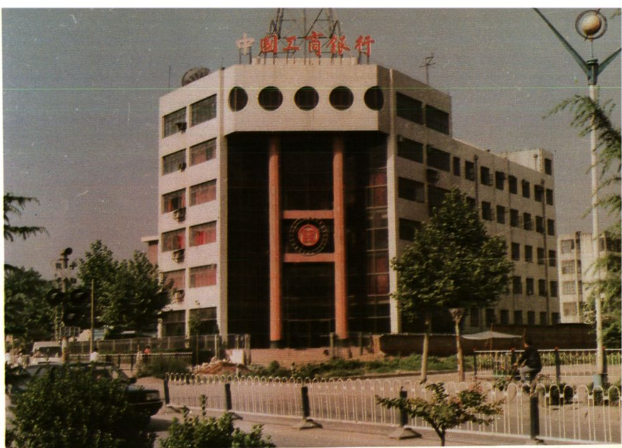
中国工商银行渭南地区中心支行办公楼
