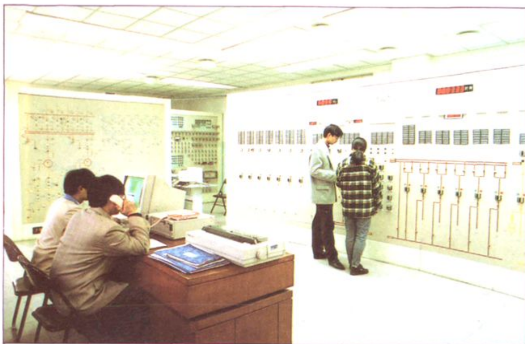
变电所仿真 培训装置
