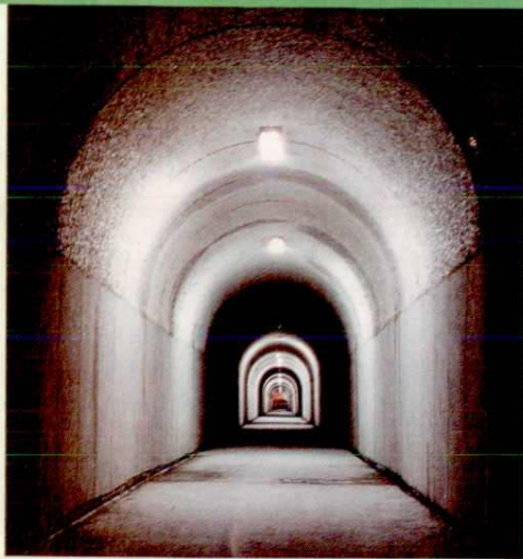
罗湾水电站,装机容量1.8万千瓦,图为厂房隧洞
