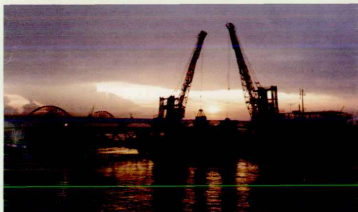
九江火力发电厂卸煤码头
