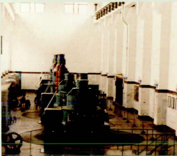
江口水电厂, 1964年9月第一台机组投产, 现装机3.52万千瓦 (郝伯泉摄)
