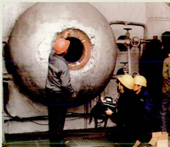
江西省电力试验研究所技术人员在现场检测锅炉汽包
