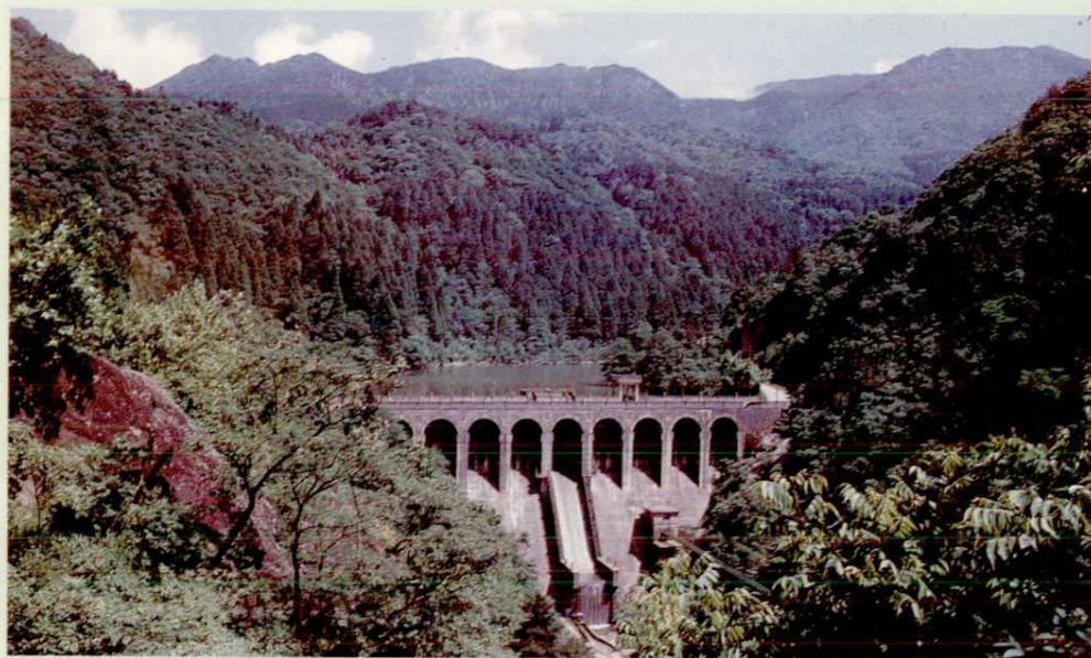
庐山水电站大坝
