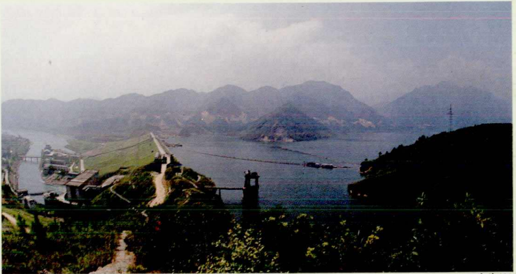
柘林水电厂大坝全景, 装机4×4.5万千瓦, 第一台机组1972年8月投产发电 (王传荣摄)
