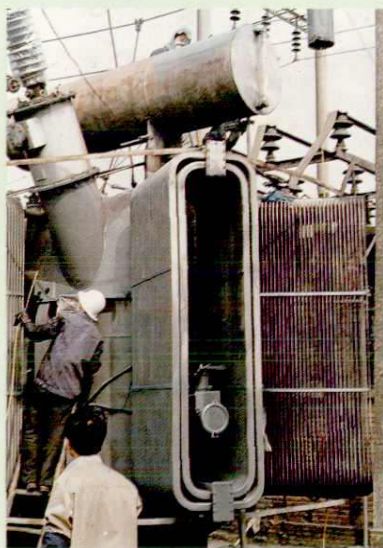
新余火力发电厂的工人正在检修变压器
