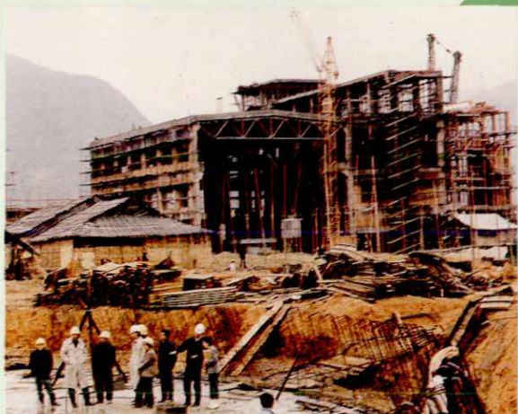
江西省电力设计院技术人员下工地服务
