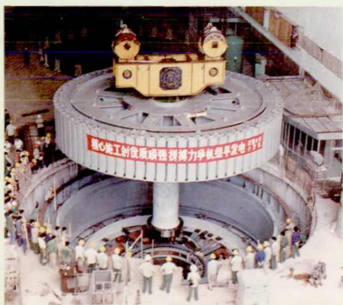
万安水电站的1号机组转子正在吊装就位
