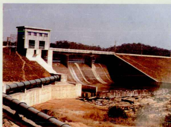
江西水电工程局的援外工程——塞拉利昂共和国哥马水电站， 装机4×1000千瓦
