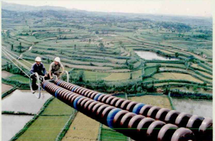
江西省送变电建设公司工人正在葛洲坝——上海 500 千伏直流线路上施工,该工程获 国家银质奖
