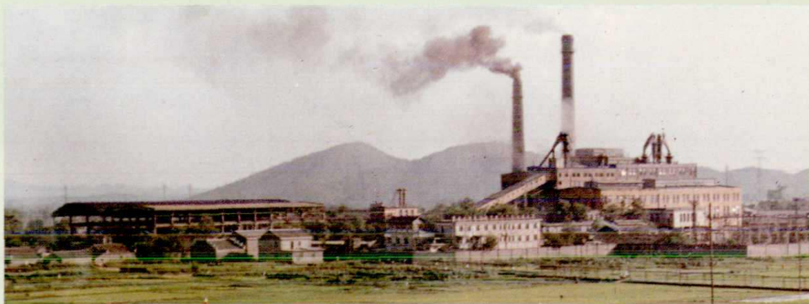
乐平发电厂现装机7.4万千瓦,1964年12月第一台机组投产
