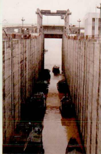
万安水电站船闸
