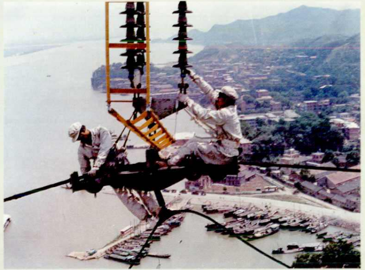
九江供电局工人在湖口铁塔上带电作业
