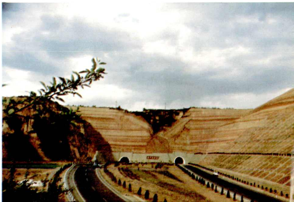
铜黄高速公路娄子沟隧道
