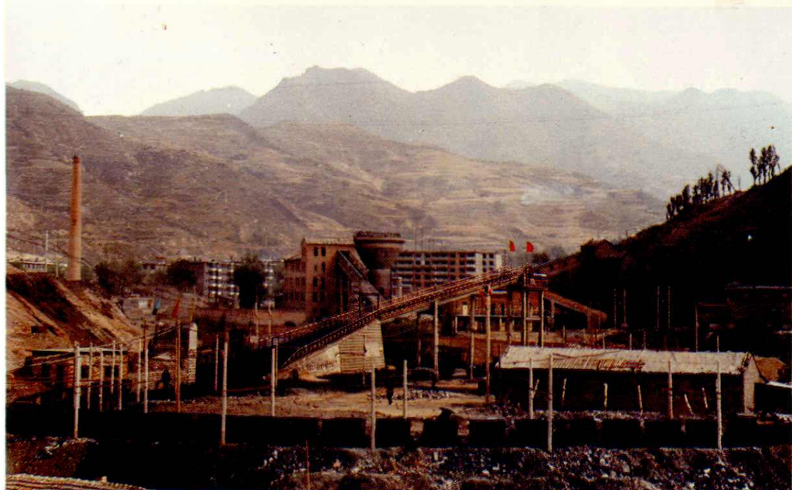
六亩地矿新建里沟井
