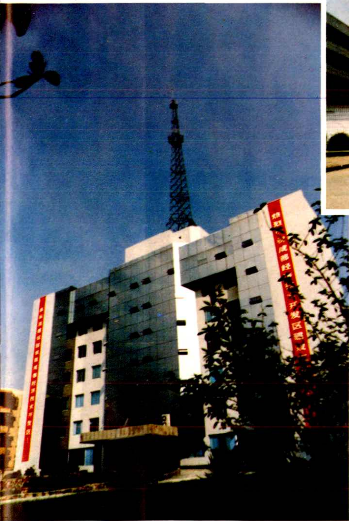
区委办公大楼
