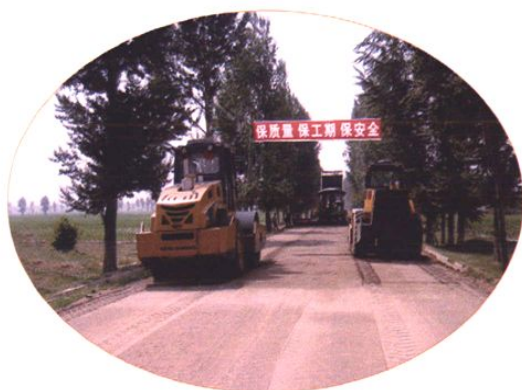
乡村公路施工现场
