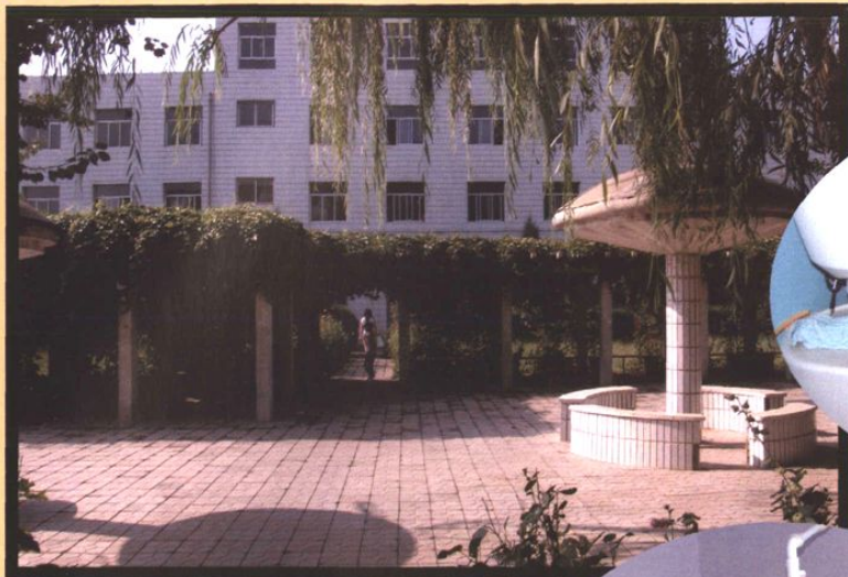
县医院住院楼
