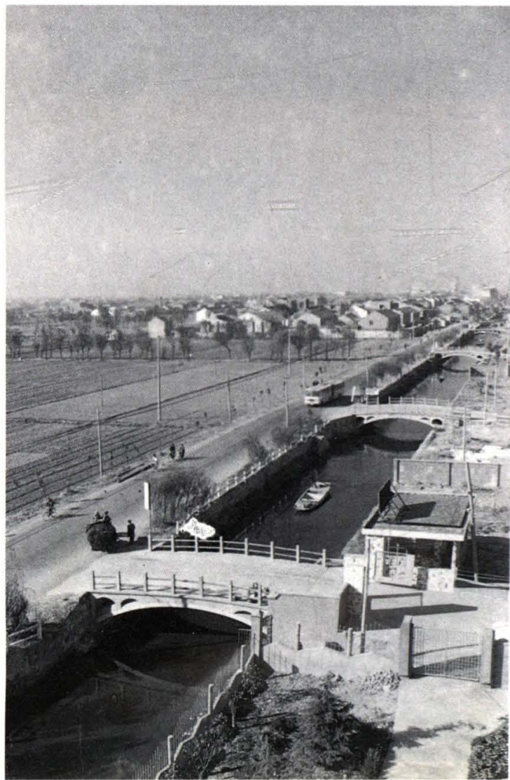
无锡水乡双曲拱桥
