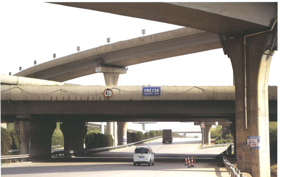
王盼庄立交桥
