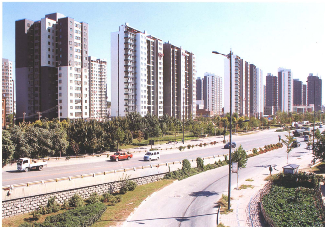
东港龙城小区
