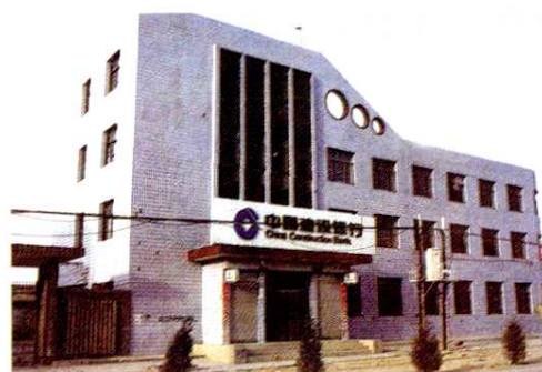
建行广灵支行办公楼
