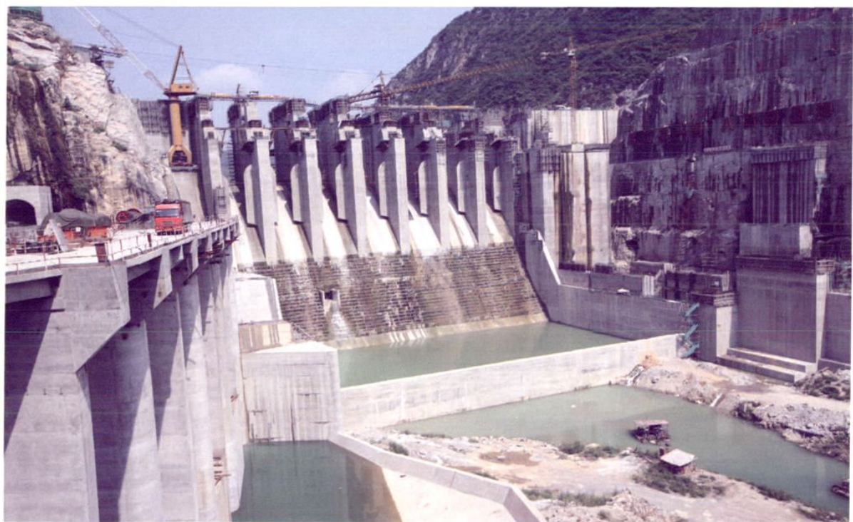
即将建成投运的思林电站
