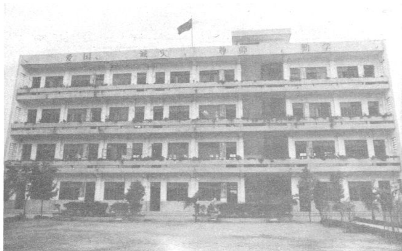
南街镇第三小学教学大楼
