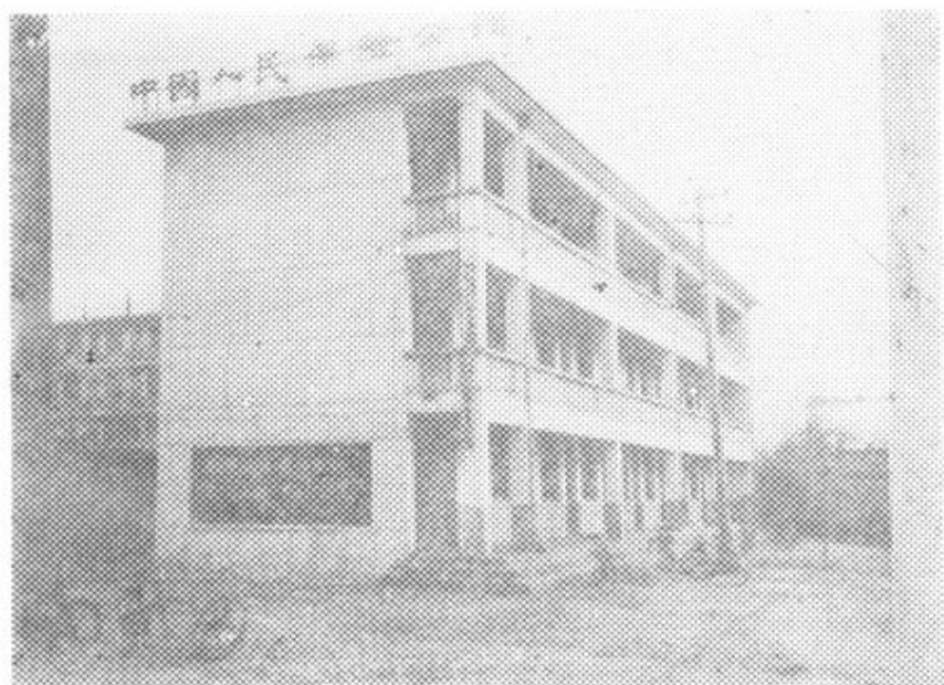
中国人民保险公司临夏州中心支公司办公楼。
