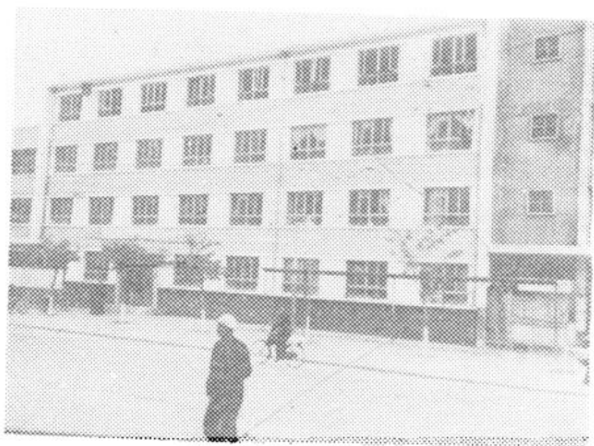
中国人民建设银行临夏州中心支行办公楼。
