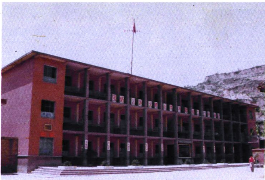
⑧延长县小学教学楼
