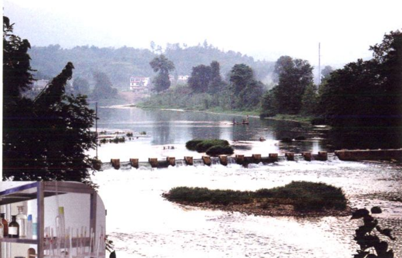
县水厂蜀江取水段
