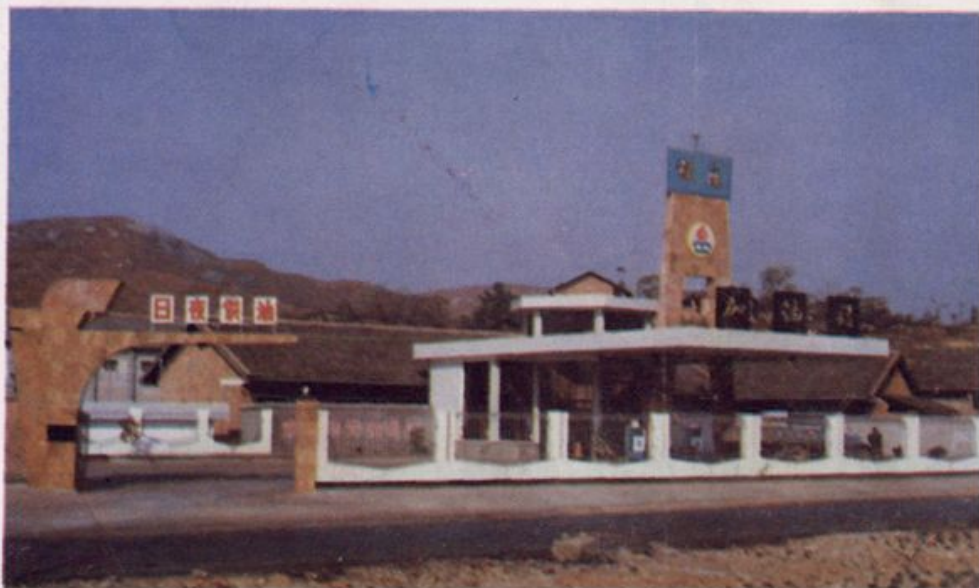
► 石门县棉麻蚕茧公司加油站。
