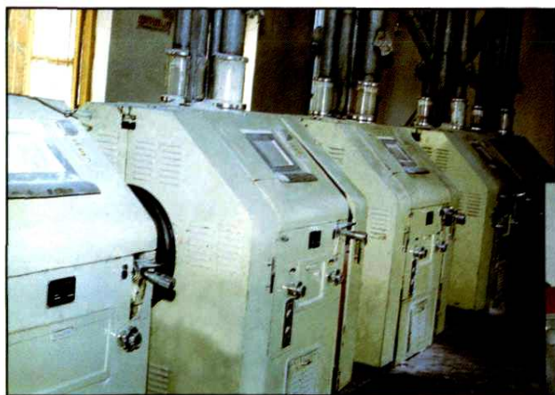
柞水县面粉厂主机车间
