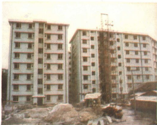
沙市工程队建造的紫云小区
