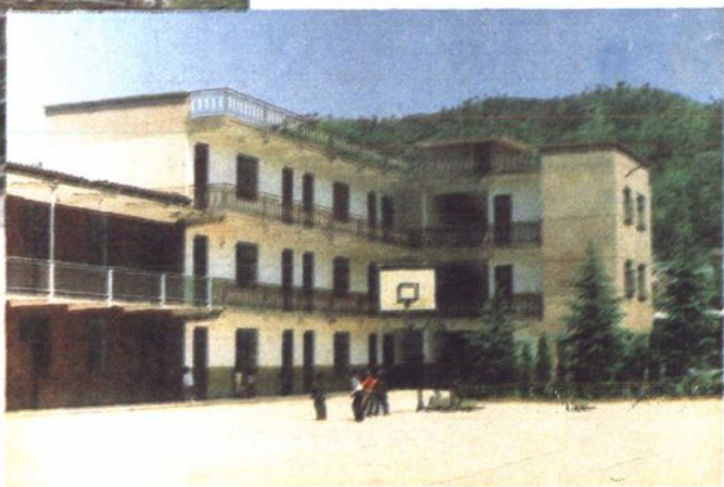
十堰工程队建造的二汽锻造厂子弟教学楼
