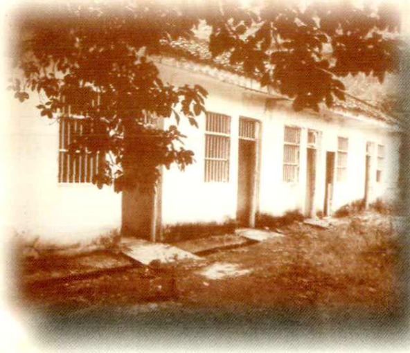
广西区电信局 205 大队总部旧址
