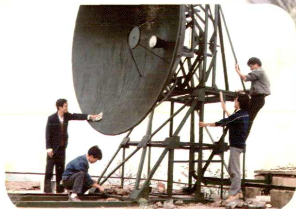
宾阳微波通信局技术人员 维护天馈线
