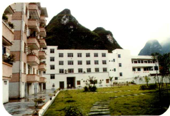
河池微波通信局全景
