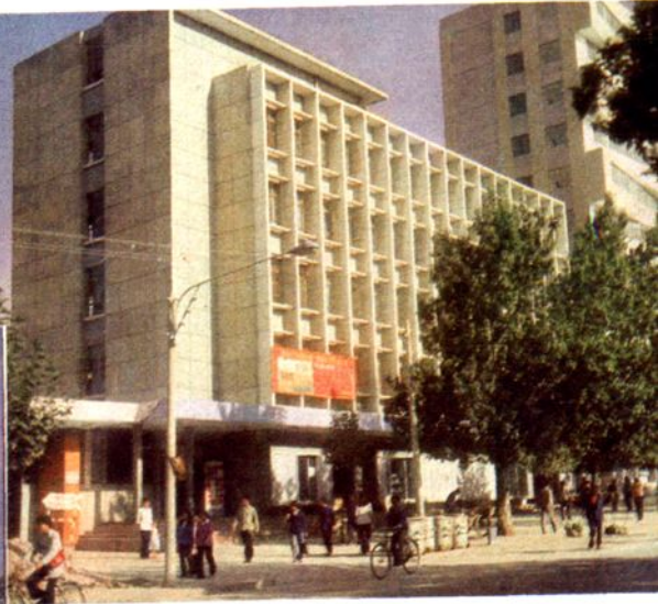
曲靖地区土产公司营业楼
