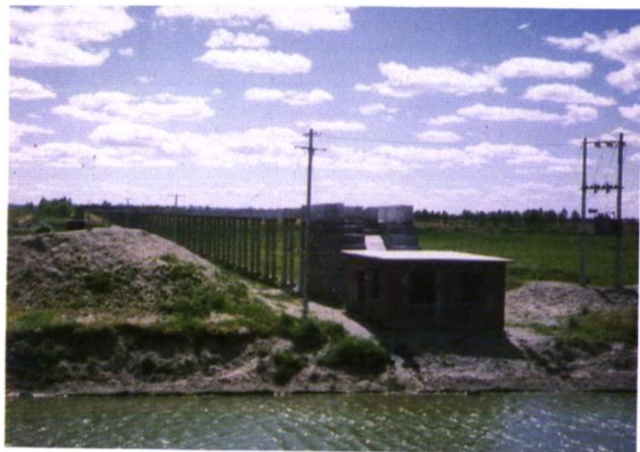
河子村扬水站
