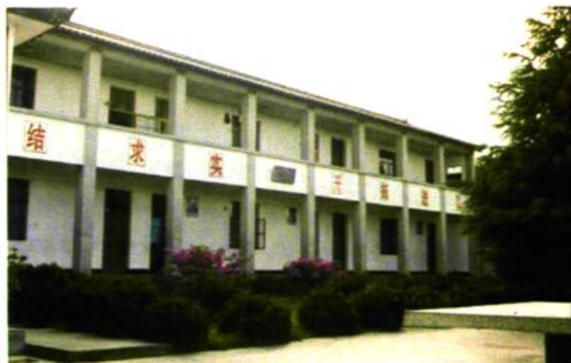
西门完小教学楼
