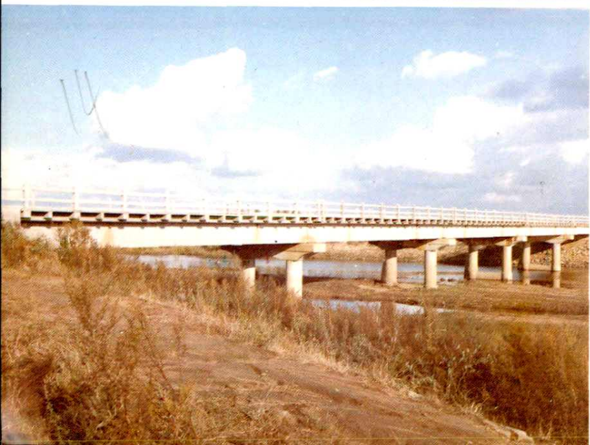
1983年，铁力农场自筹资金110万元，在依吉密河上建造一座长104米、宽9米的大桥。
