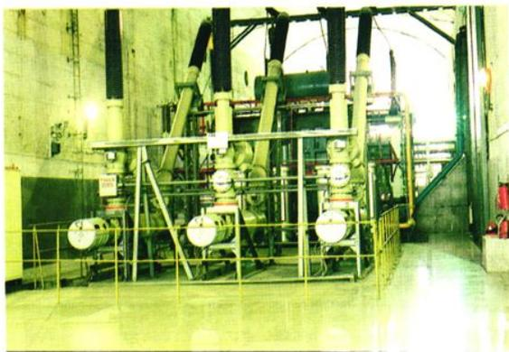
1989年进行主变洞设备改造，图为改造后的六氟化硫(SF6)开关。
