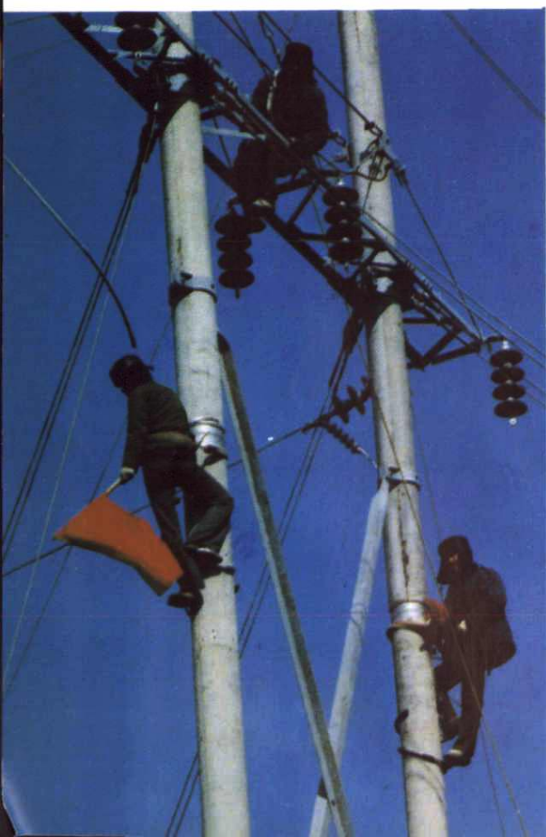
高压线路安装
