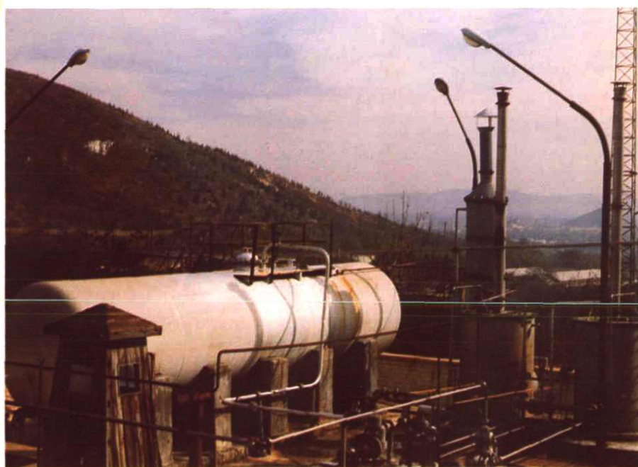
水胶炸药车间辅助设施
